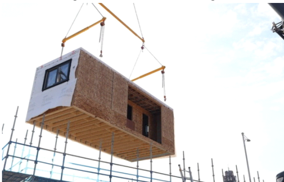
[모듈러 주택 설치 모습]
