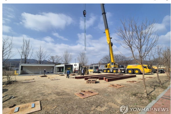
[모듈러 주택을 설치하기 위한 기초 바닥 공사]
