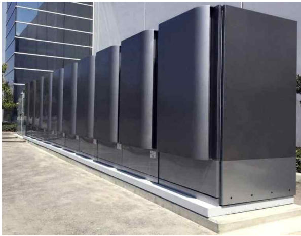
[그림] Bloom Energy사 300kW SOFC 시스템
