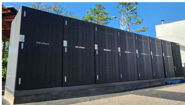
[그림] 미코파워의 150kW SOFC 시스템 (25kW 모듈 6개로 구성)
