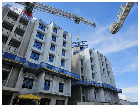
[그림] 싱가포르 Tengah C8 site, PPVC 시공현장
