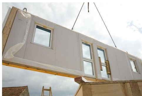
[그림] 영국 MMC 패널라이즈드 공법
