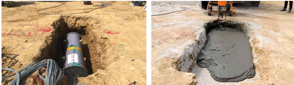
[그림] 굴착복구 시험시공 전경
