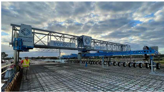
그림 39. 철근결속 로봇 TyBot (출처: Advanced Construction Robotics)
