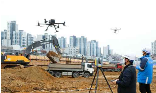
그림 49. 드론을 활용한 건설현장 측량 (출처: 뉴데일리경제) 및 해상공사 품질 확인 (출처: 에너지경제)
