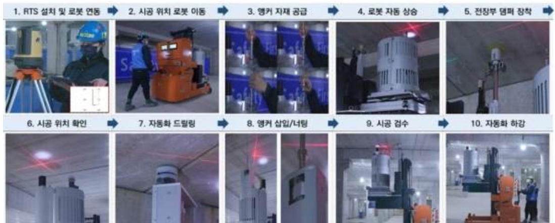
그림 37. 건설용 앵커설치 로봇 (출처: 삼성물산)
