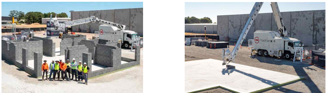
그림 42 벽돌쌓기 완전자율 로봇 HadrianX (출처: Fastbrick Robotics)
