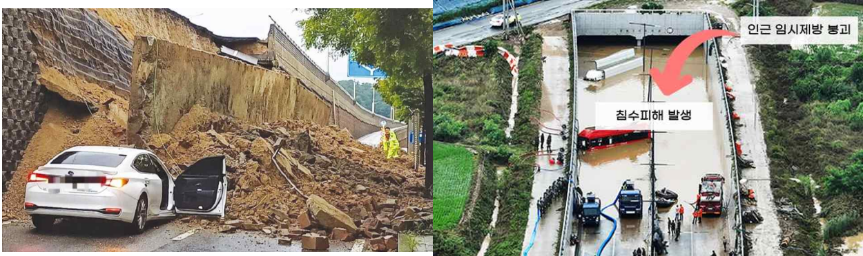
〈 오산시 가장교차로 고가도로 옹벽 붕괴 사고('25.07) 〉 〈 청주 오송읍 궁평2지하차도 침수 사고('23.07) 〉
