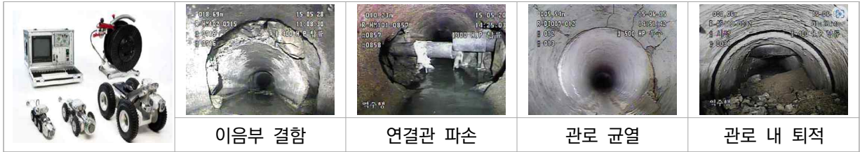
【 CCTV를 이용한 하수관로 내부 점검(예) 】
