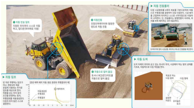
<AACSEL 시스템 기반 토사반입 및 성토작업 자동화>
