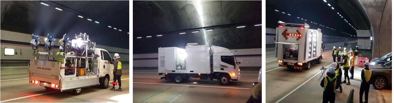
[그림 2-93] 차량 탑재형 터널스캐너 점검(KMTL, 아워브레인, 딥인스펙션/SQ)
