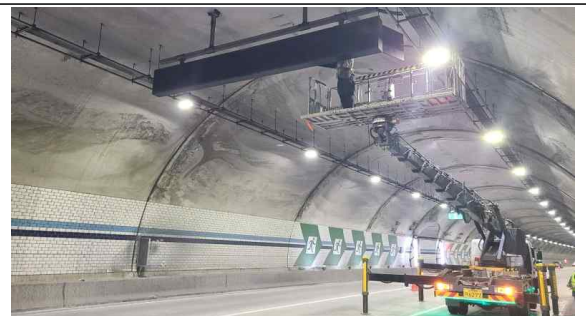
&lt;터널 VMS 보수&gt;
