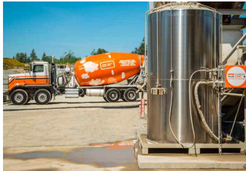
[그림 2-35] Carboncure社の 레미콘 CO 2 주입기술
