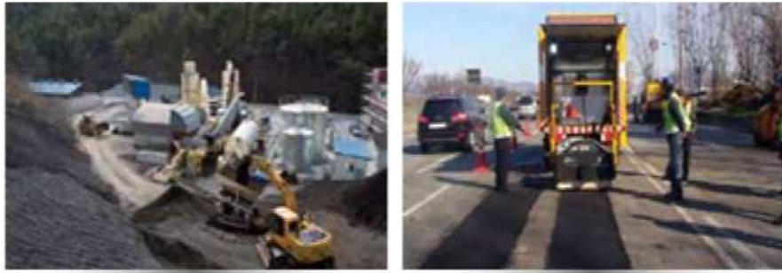
[그림 2-42] 상온 재활용 아스팔트 포장 기술
