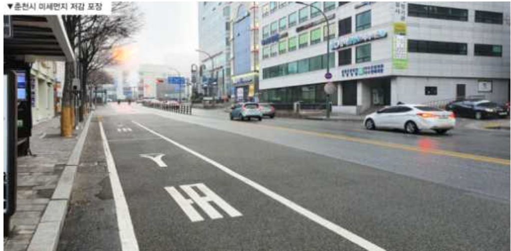
[바이오 폴리머 콘크리트 설치 사례]
