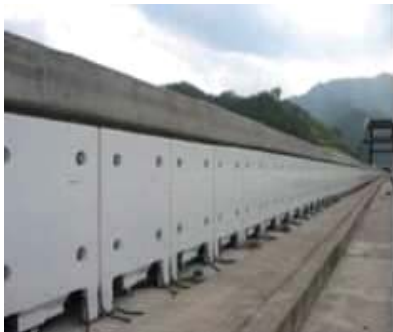
[그림 2-30] 일체형 및 케이블형 추진용 전자레일(일본)
