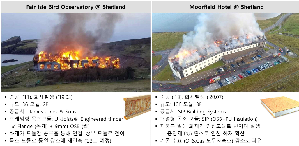
<그림 4.7> 화재확산방지구조 미흡에 따른 목조 모듈러 건축물 화재 전파 사례
