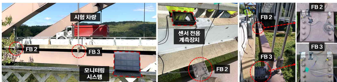
[개발기술 현지 교량 부착 및 재하시험 중 성능 검증]
