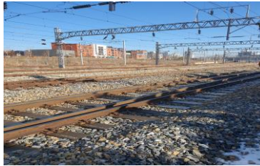
서울교통공사 (교량용) 동호동작교
