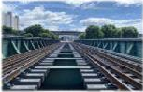
<현장실증 시험시공 현장 (청량리 한천교)>
