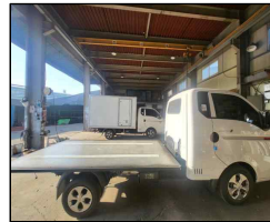
③샤시 상판 설치
