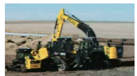
(자율 시공 굴삭기 및 도저, 美)
