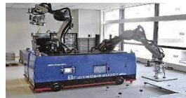
〈 바닥판 설치 로봇 〉
