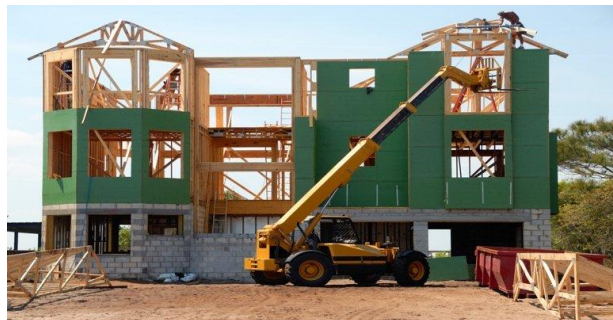
[그림] Home to Build 제도를 통한 주택 건설 현장
