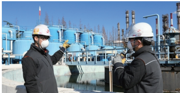
[그림] SK에너지 동력공장 제1 종합폐수처리장 현장
