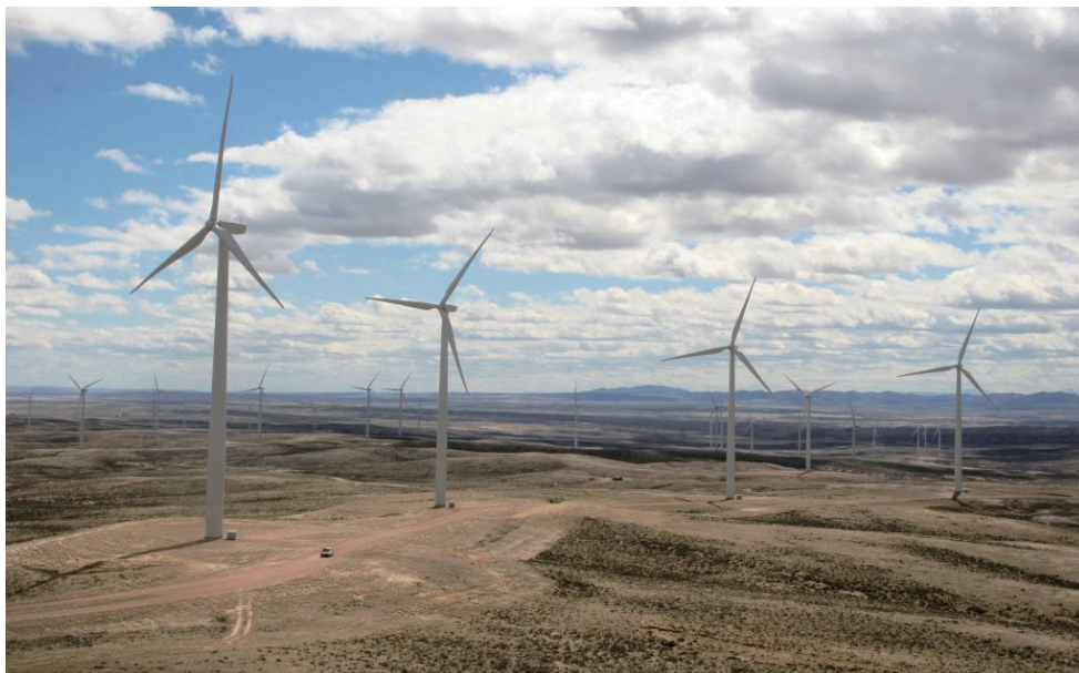
[그림] Duke Energy의 GE 풍력 터빈을 사용한 풍력발전단지
