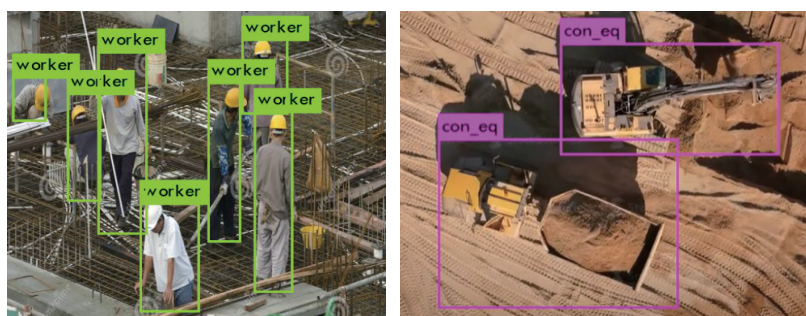
[그림] YOLO 기반 시설물 작업자 안전관리 예시
