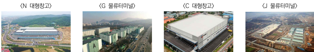
<그림 1-2> 대형 물류창고 전경
