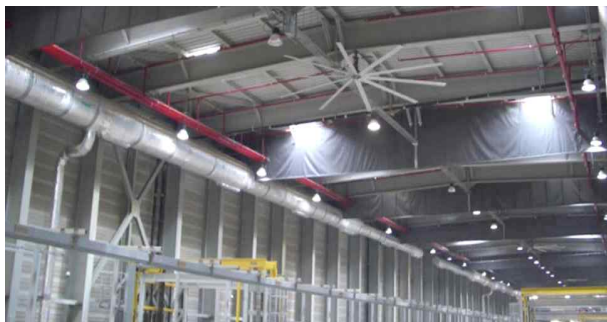
<그림 2-55> 물류시설에 설치한 Smoke Curtain 사례
