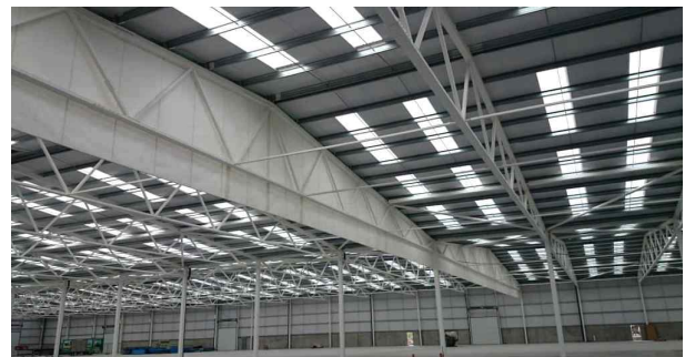
<그림 2-55> 물류시설에 설치한 Smoke Curtain 사례
