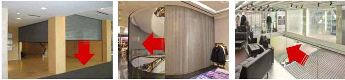
〈그림 2-31〉 방화셔터의 개폐방향 및 적용부위에 따른 구분
