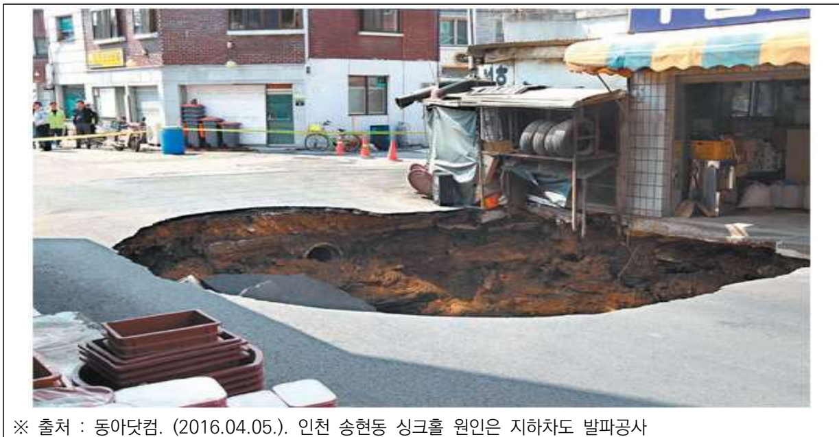
[그림 2-15] 발파 방식의 터널굴착 공사로 인한 싱크홀 발생 사례
