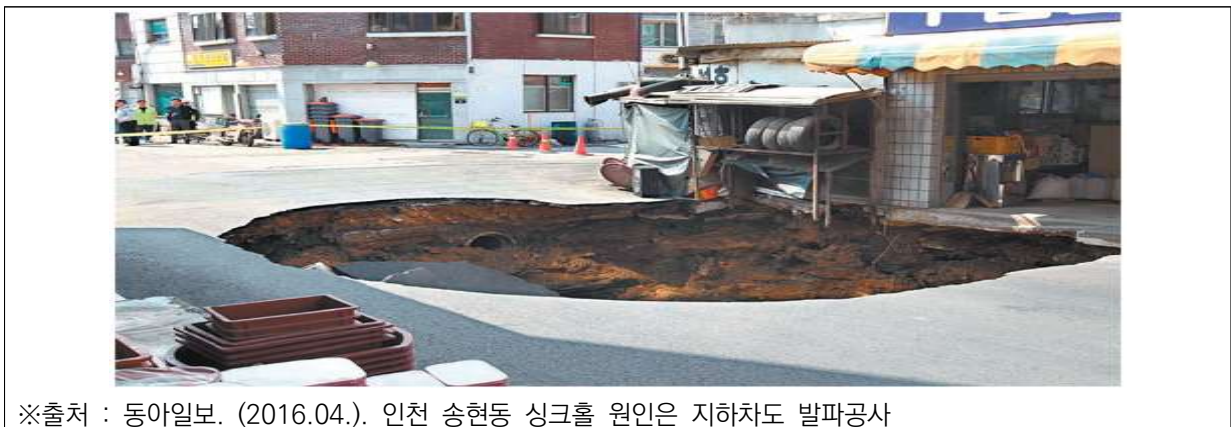
[그림 1-8] 발파 공사로 인해 발생한 인근 지역의 싱크홀
