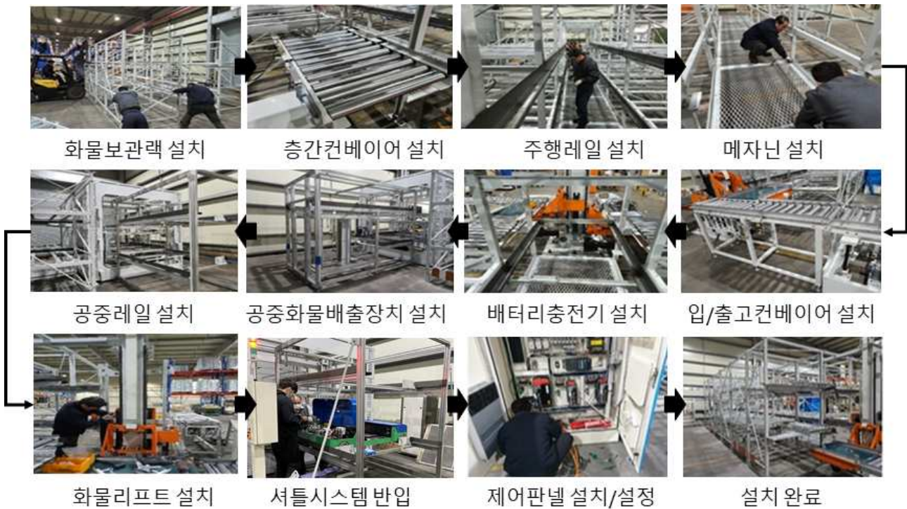
[그림 25] 셔틀 시스템 설치 순서 및 방법
