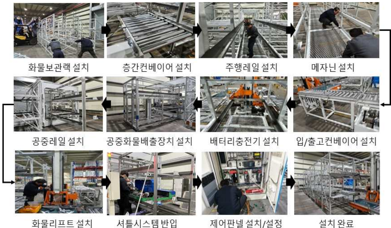
[그림 2] 서틀 시스템 설치 순서 및 방법
