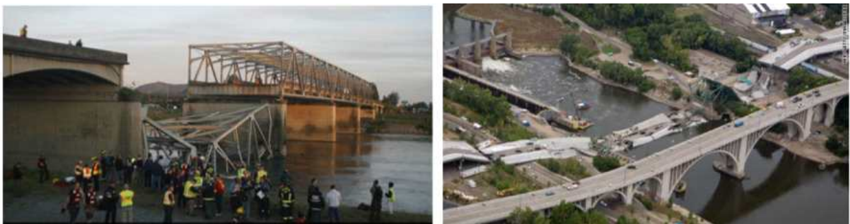
<그림2-13> 미국 Skagit County, Minesota 교량 붕괴 사고
