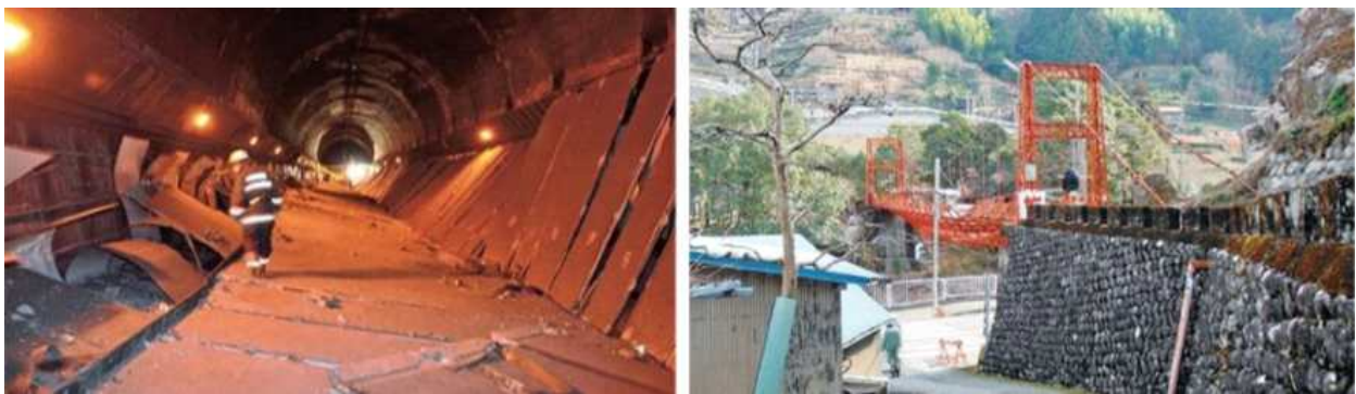
<그림2-16> 일본 사사고 터널 붕괴, 다이이치벤텐바시 파손 사고
