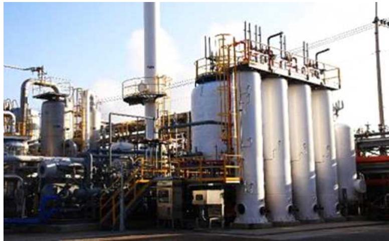
[그림 2-2-9] 국내 덕양에너지사에 구축된 젠스엔지니어링사의 수소 PSA 설비 (출처: 한국에너지신문, http://www.koenergy.co.kr/news/articleView.html?idxno=55517 , 2011)
