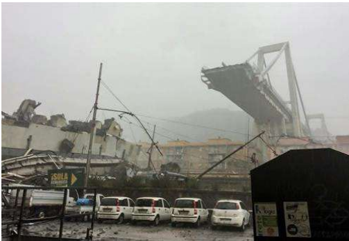
[그림 2] 이탈리아 고속도로 교량 붕괴
