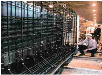
(a) CFRP 긴장재 및 스티럽(Headingley bridge 거더) (b) CFRP 그리드 및 보강근(Joffre bridge 데크 슬래브)
