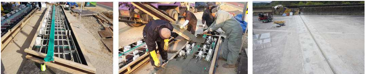
[그림 34] GFRP 보강 콘크리트 바닥판 시공 현황
