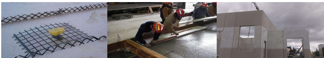
[그림 18] C-Grid에 의한 CarbonCast 제작 및 설치 모습
