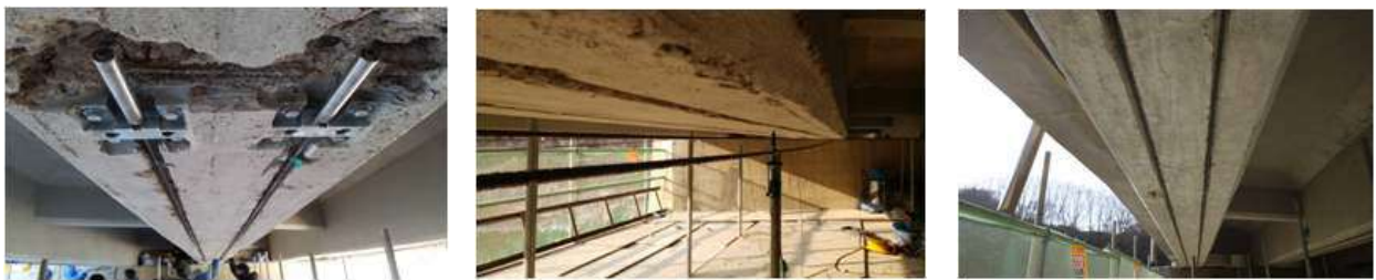
* 출처 : 노후 교량의 sogkurgid상7 FRP 긴장보강공법 개발 4차년도 보고서, 한국건설기술연구원, 2016.
