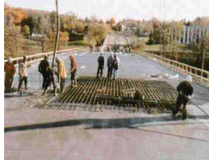
(a) CFRP 긴장재 및 스티럽(Headingley bridge 거더) (b) CFRP 그리드 및 보강근(Joffre bridge 데크 슬래브)
