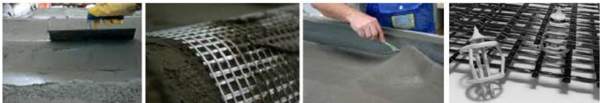
[그림 6] CFRP 그리드를 활용한 시공 및 부속물 예시
