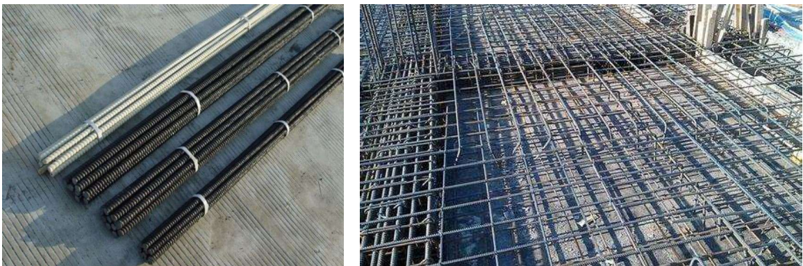
[그림 89] 탄소보강근-콘크리트 시공 예시
