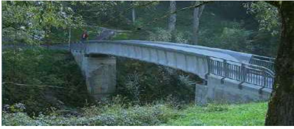
(a) 도로교, Rottachsteg bridge
