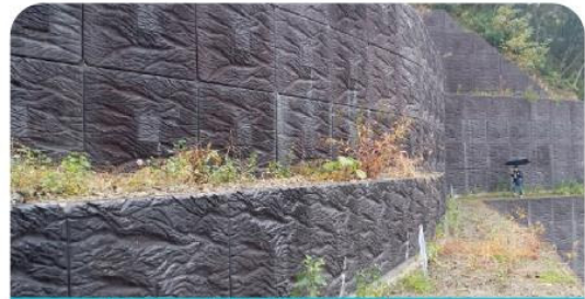
경량 프리캐스트 패널을 이용한 원지반 부착방식의 절토부 옹벽 기술
