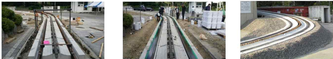
레일 부설 및 정정 탄성 충전재 타설 완성된 시험궤도
