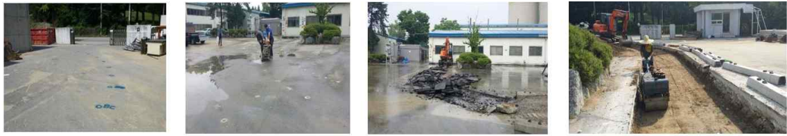
중심선 측량 도로 컷팅 작업 콘크리트 철거 작업 절토부 진동 다짐
