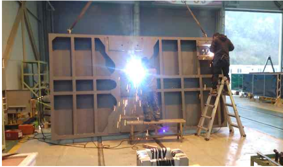
<차체 프레임 용접 조립>
