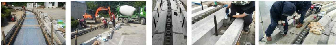
HSB 층 거푸집 작업 HSB 층 타설 패널 거취/Rack 설치 배당재 타설 전단 앵커 설치
