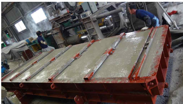
<콘크리트 타설 작업 완료>
