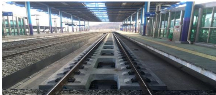
[그림 4.313] 대전역에 시범 설치된 사전제작형 플로팅 슬래브 궤도
