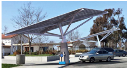
[그림 4.6] 태양광 충전소 (Solar Tree DC 급속충전 사례)
