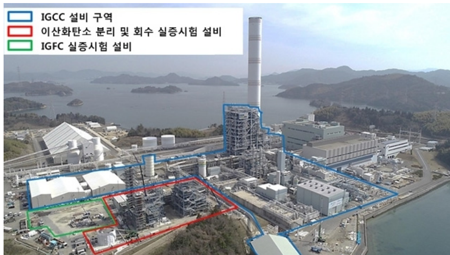
[그림 4.321] 주오쿠전력 오사키발전소 부지 내 IGFC 실증사업 설비 배치도
