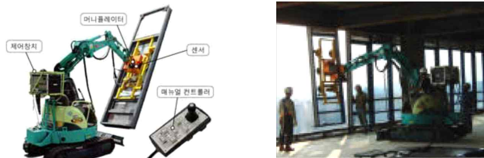
[그림 16] 커튼월 설치 자동화 기술
