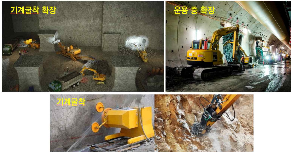
<그림 6-6> 운용 중 확장을 위한 기계굴착 예시
