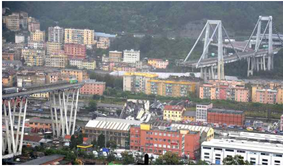
Ponte Morandi(이탈리아) 교량 붕괴
