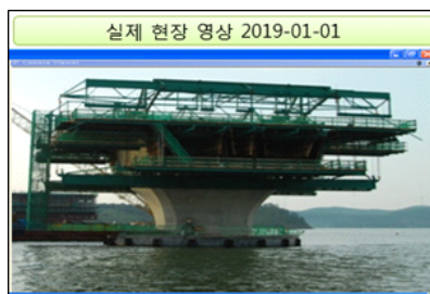
실제 시공 모습
