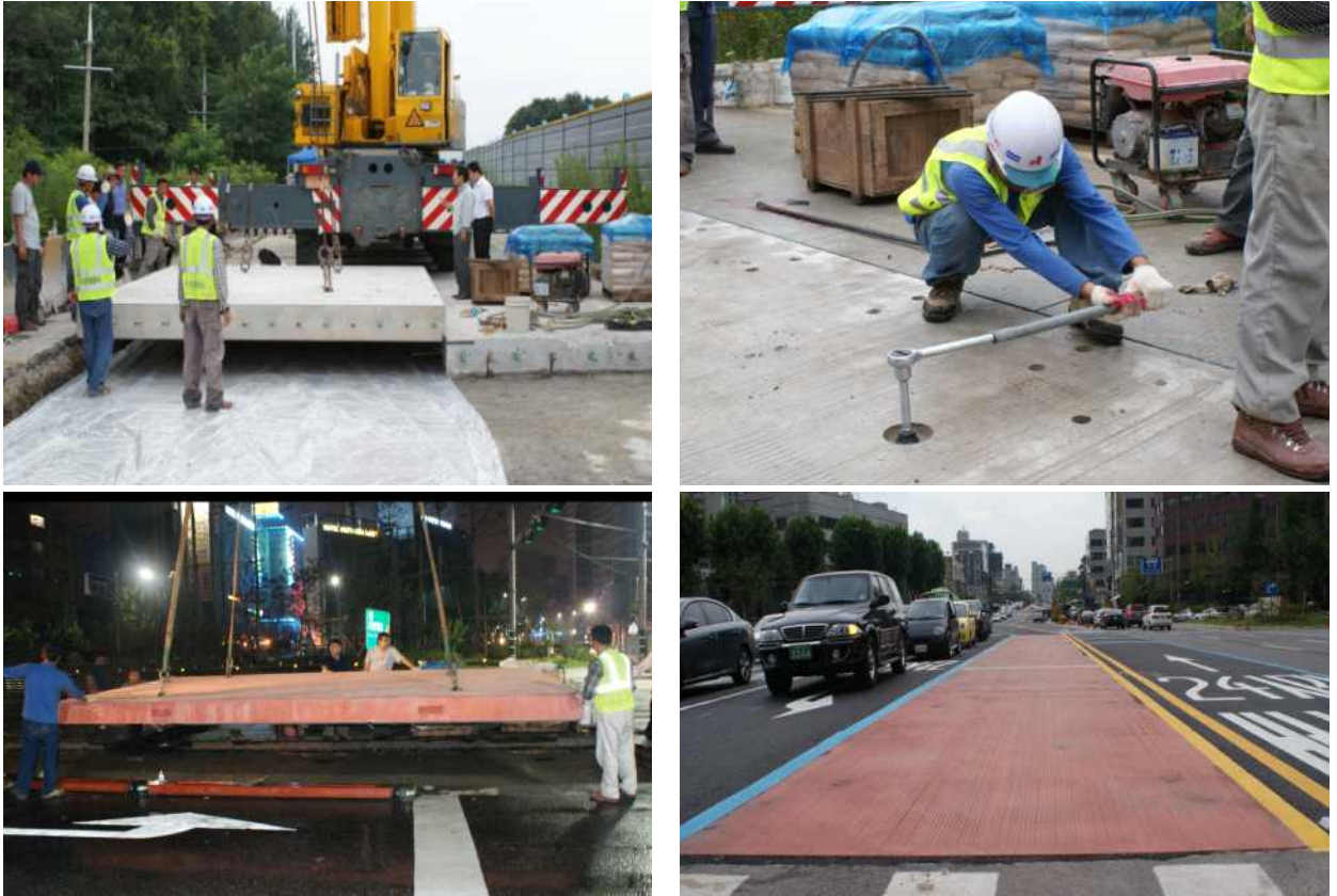
그림 2-2-36 프리캐스트 콘크리트 시공 및 준공 전경
