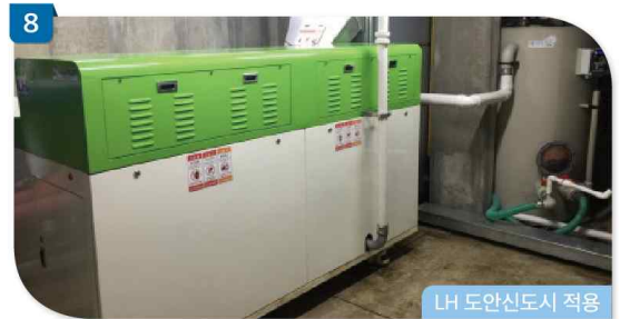
8 LH 도안신도시 적용 주거단지(발생원) 내 자체 음식물쓰레기 처리시스템
