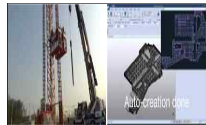
< 더블데크 리프트 시운전 및 골조/외피 상세 설계도구 >
