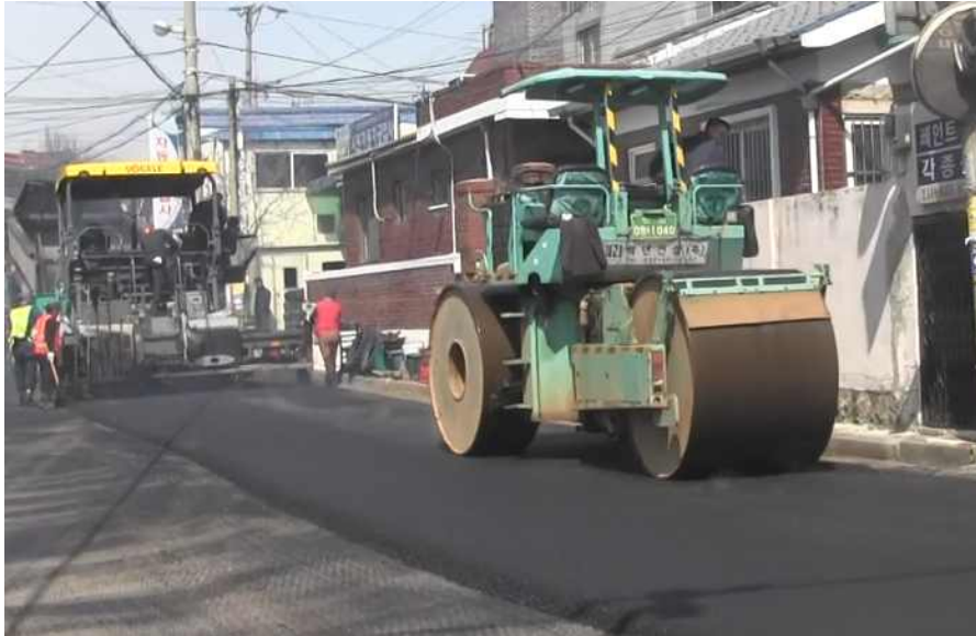
〈포장 시공 현장 모습 예〉
