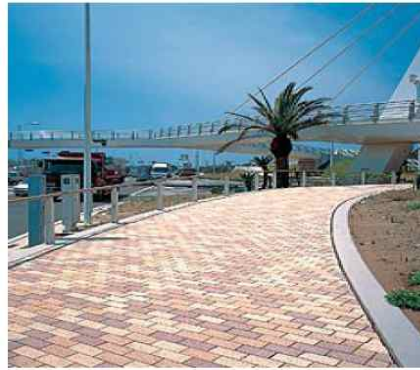
그림 2.18 Block Pavement for Japan Photocatalytic Concrete (Anne Beeldens et. al., 2006)
