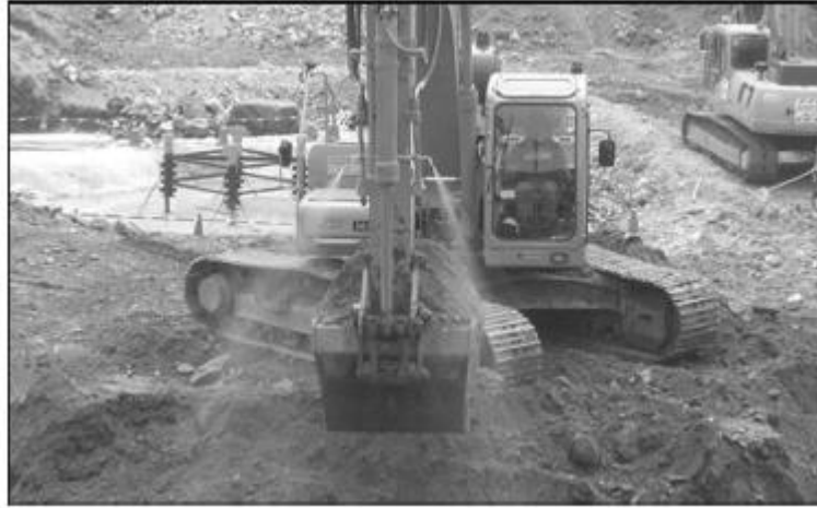
그림 2.15 건설공사장 굴삭기 장비 살수 부착
