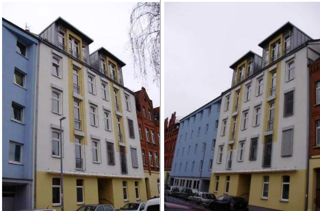
개선후 주택의 전경
