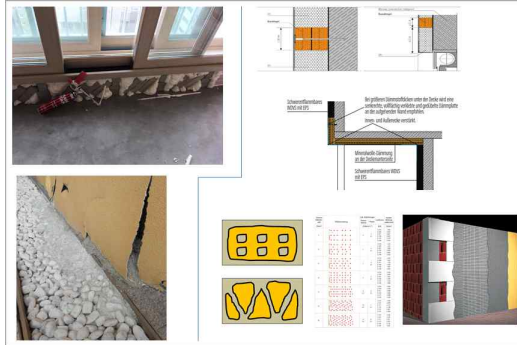
그림 150. 국내 리모델링 시공 사례(좌)와 국외 시공 예시도(우)
