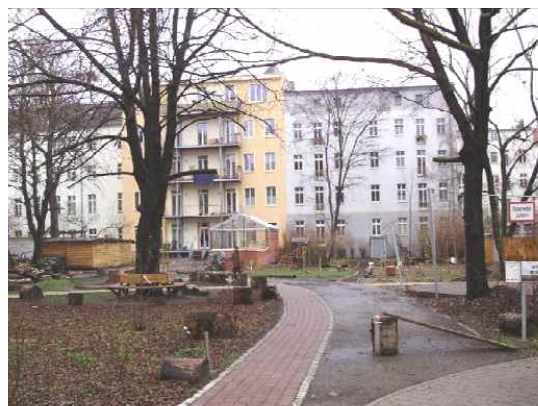
개선 후 주택의 전경
