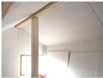
단열재 보강 시공
