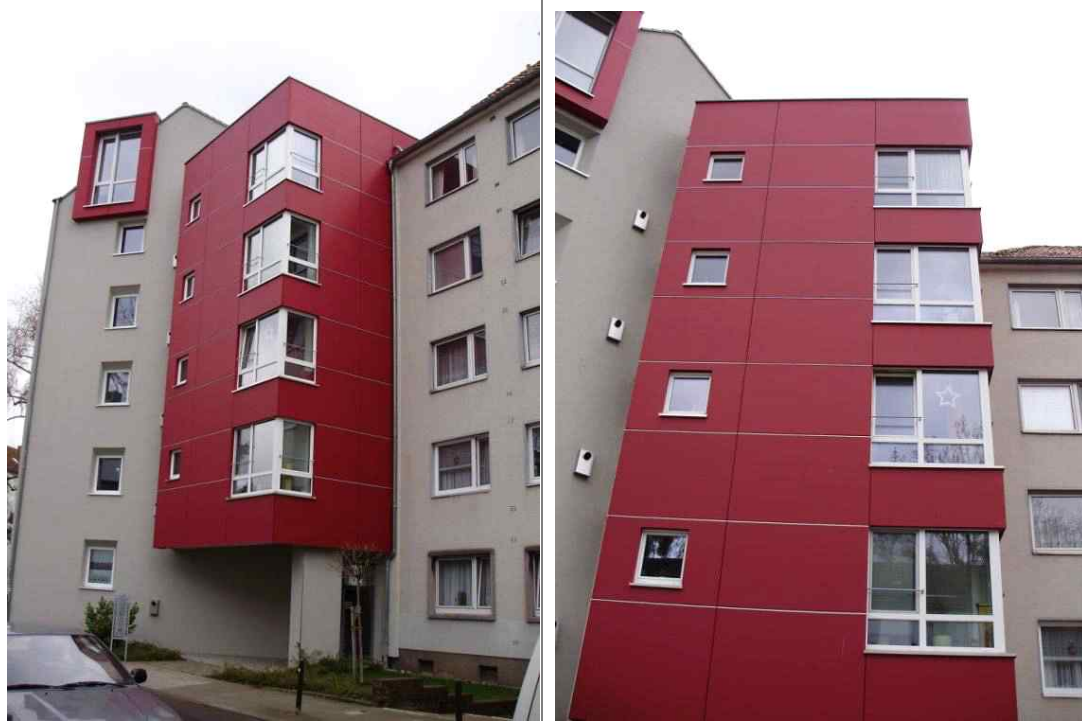
개선후 주택의 전경
