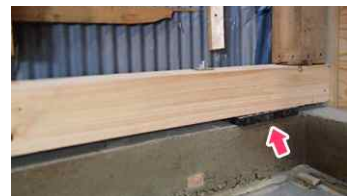
방진 고무 기초 패킹 시공
