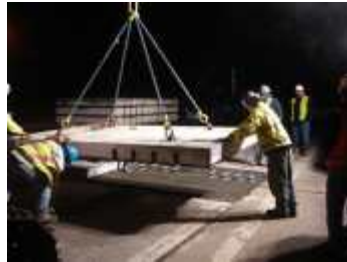
프리캐스트 콘크리트 포장
