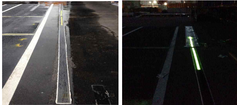
그림 77 EL-tape과 투명바인더 시공 예시 및 작동모습
