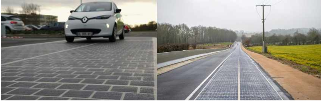
그림 25 프랑스 노르망디에 시범 설치된 태양광 도로
