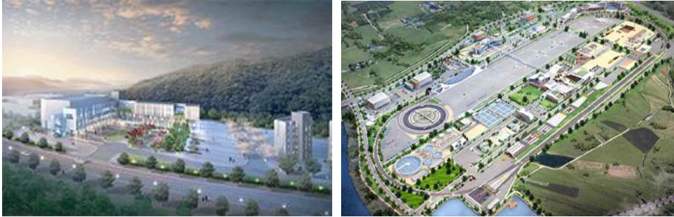
그림 124 국토교통부 기상환경 재현 도로 성능 평가 실험시설 조감도
