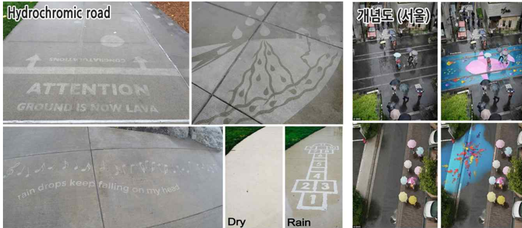
그림 69 수분 변색 안료 도로 적용 및 개념도
