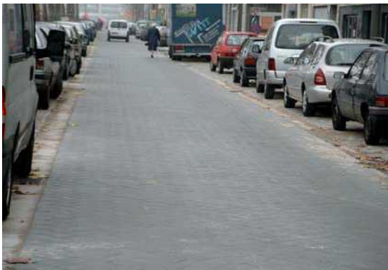
그림 70. 광촉매 콘크리트 블록 포장 적용 사례 (벨기에)
