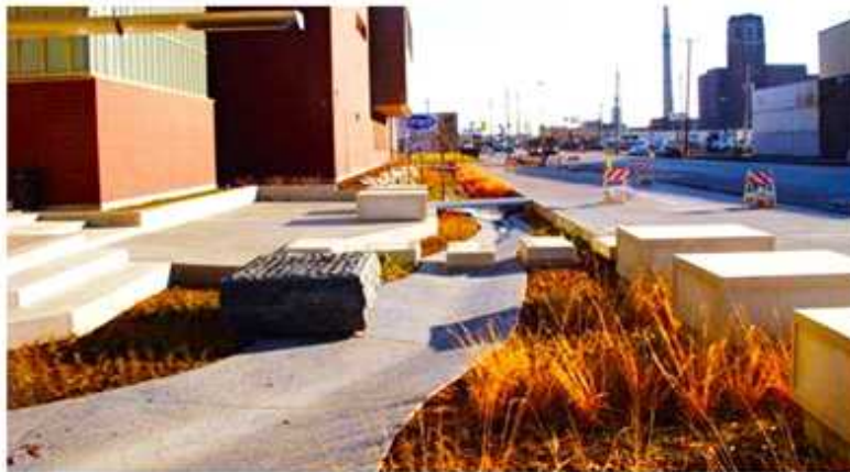
그림 56. 미국 시카고 광촉매 적용 도로 시공 사진
