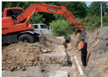
수재생 지하저류조 하천수 유입관로 시공
