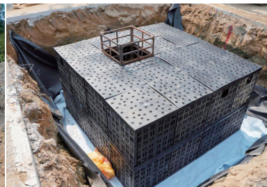
수재생 지하저류조 시공
