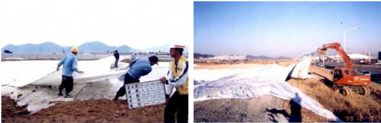
[그림 1-7] 기존 토목섬유 MAT 포설 방법 사례
