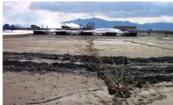
[그림 1-9] 간접포설에 의한 시공 예시 (SKID 공법)
