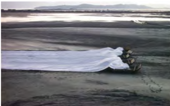
[그림 1-9] 간접포설에 의한 시공 예시 (SKID 공법)
