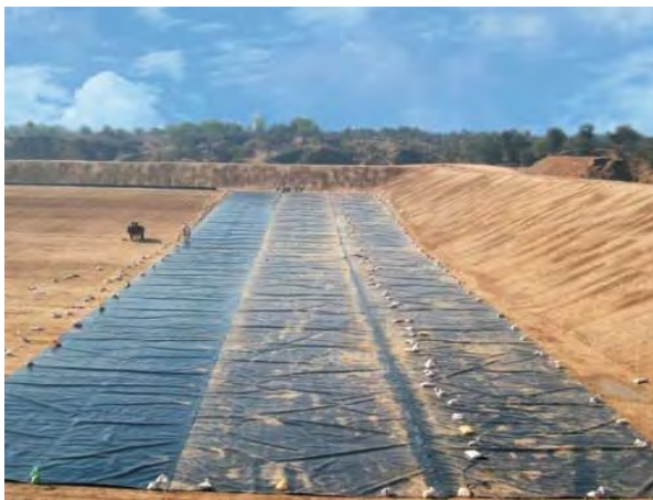
<인장매트 설치 및 봉합 광경>
