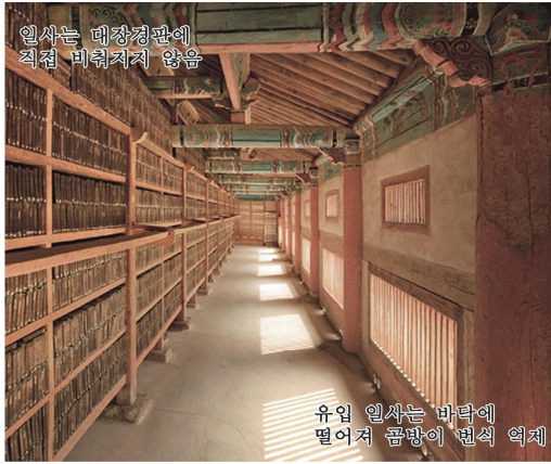
그림 115. 장경판전의 일사 조절 시스템 분석
