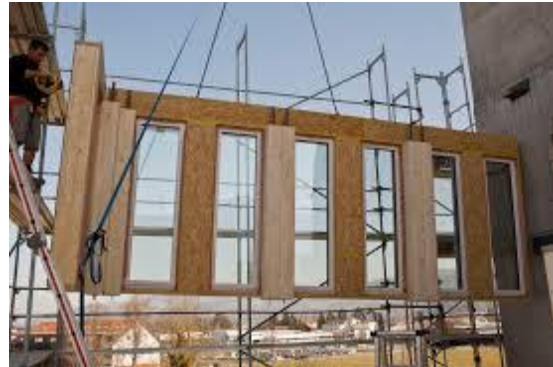
그림 173. LCT ONE(목재 프리패브 파사드 시공)
