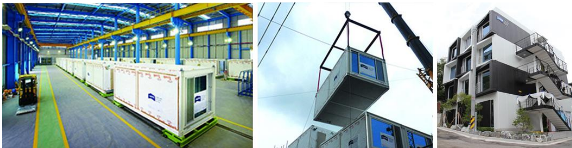
그림 58. 모듈러 제작 및 설치 모습
