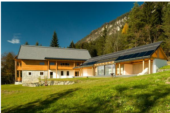
그림 174. Der Weber Haus(목조 리모델링 패시브 하우스)
