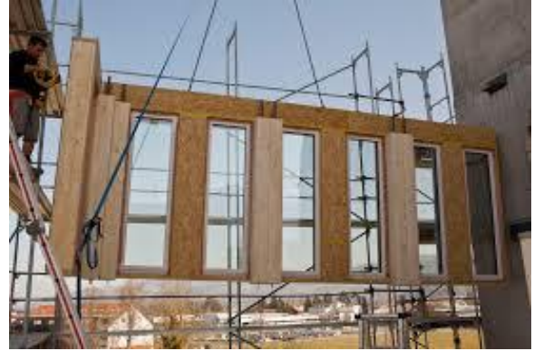
그림 58. LCT ONE(목재 프리패브 파사드 시공)
