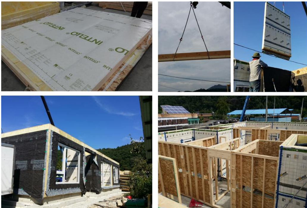
그림 91. 국내 중소기업의 Prefab 경량목구조 건축물 시공 현장의 모습
