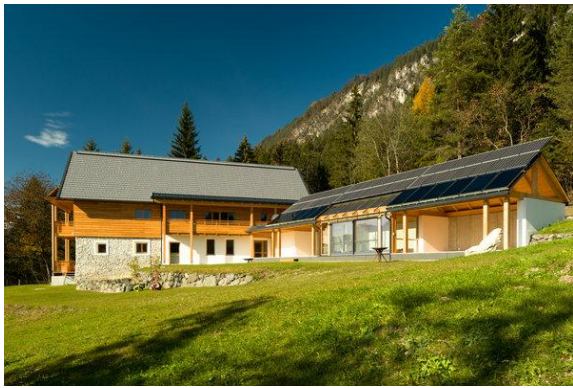
그림 59. Der Weber Haus(목조 리모델링 패시브 하우스)
