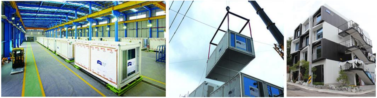
그림 20. 모듈러 제작 및 설치 모습
