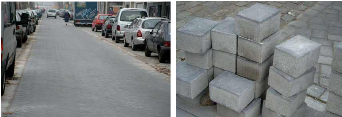
그림 70. 광촉매 콘크리트 블록 포장 적용 사례 (벨기에)
