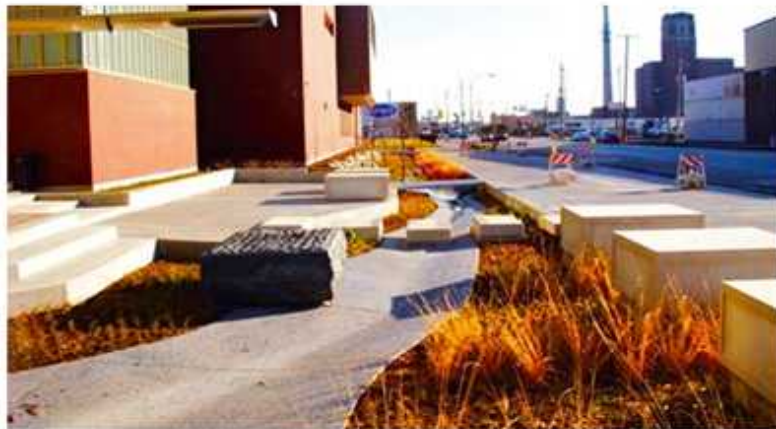
그림 56. 미국 시카고 광촉매 적용 도로 시공 사진
