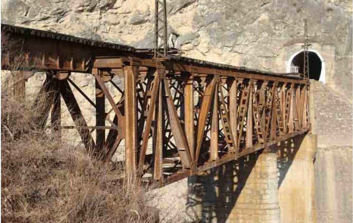
<금골선 본선 1개교(Steel. Truss Girder교)>
