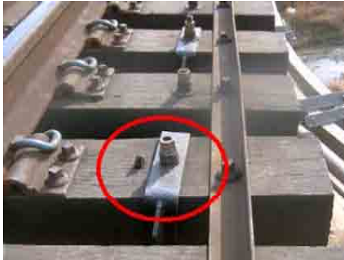
<침목-거더 체결장치 현장부설 예>
