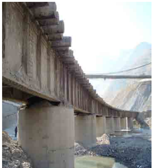
<검덕광산 광산전용철도 1개교(Steel Plate Girder교)>
