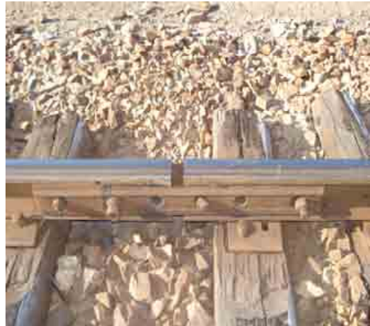
<레일 이음매부(이음매판) 체결상태 현황>
