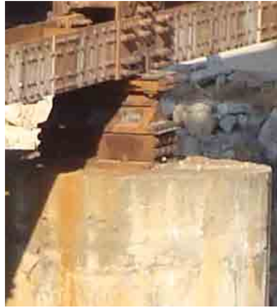
<그림 2.3 Steel Plate Girder교 내부> <그림 2.3 교량 교각(불안정한 슈)부분>
